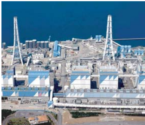
環境対策（発電所）
